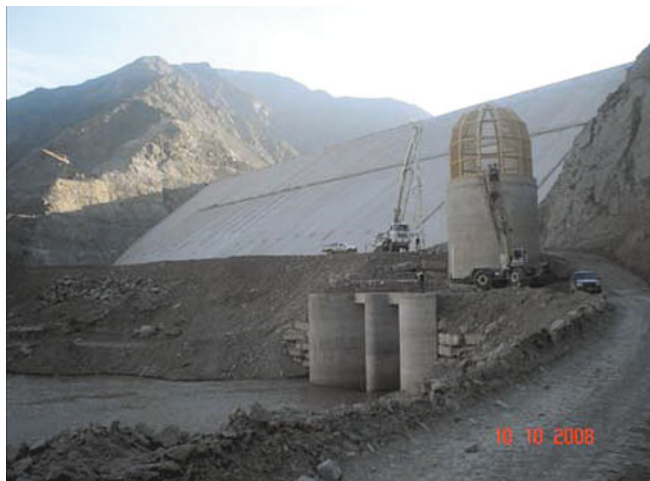
Рис. 3. ГЭС Лос-Караколес: входной оголовок туннеля отвода реки
