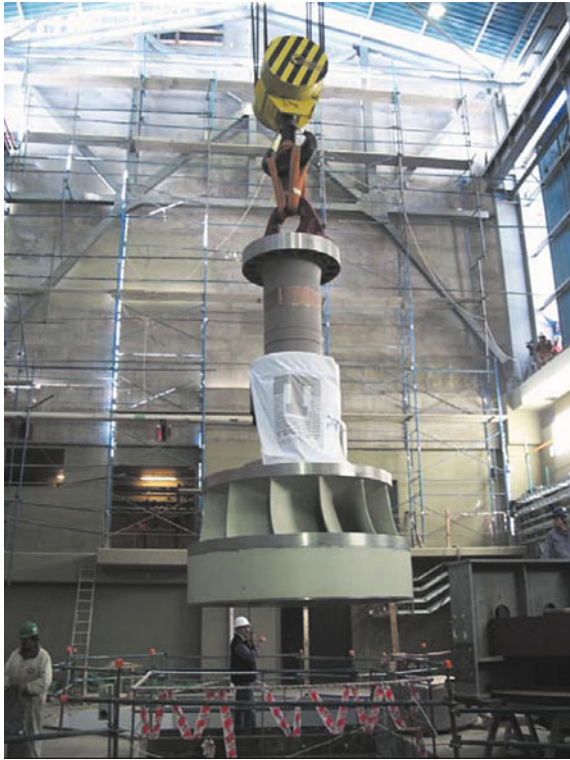
Рис. 13. ГЭС Лос-Караколес: опускание рабочего колеса гидротурбины в кратер
