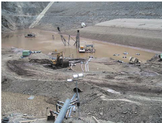
Рис. 11. ГЭС Лос-Караколес: затопление пазухи между плотиной и верхней перемычкой
