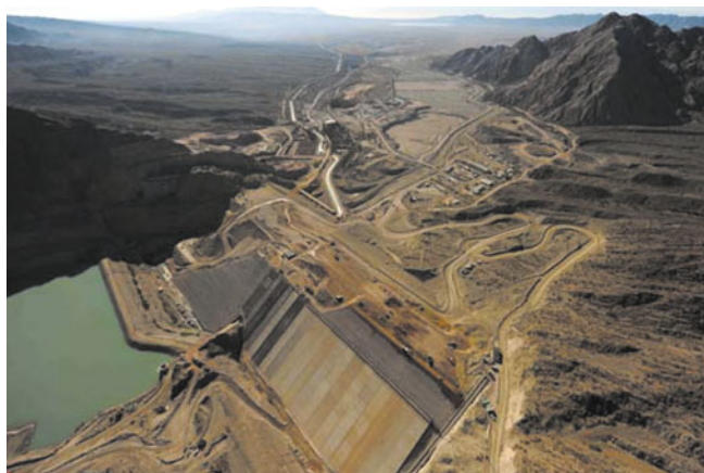
Рис. 10. ГЭС Пунта-Негра: строительство плотины с железобетонным экраном
