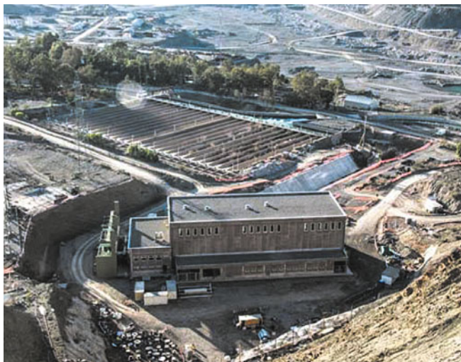
Рис. 9. Здание ГЭС Пунта-Негра
