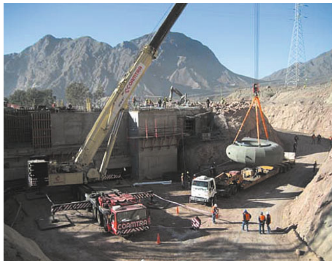
Рис. 16. ГЭС Пунта-Негра: монтаж “с колёс” статора со спиральной камерой гидротурбины
