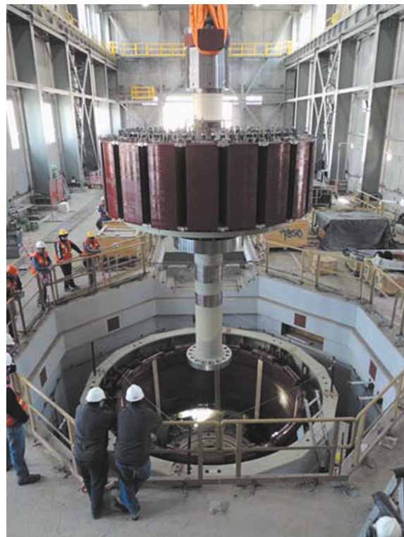
Рис. 17. ГЭС Пунта-Негра: опускание ротора гидрогенератора в кратер
