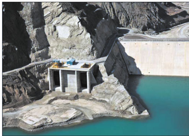
Рис. 4. Водозаборные отверстия туннельного водосброса ГЭС Лос-Караколес
