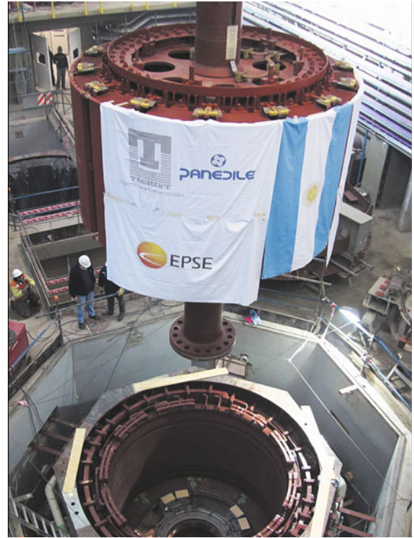
Рис. 14. ГЭС Лос-Караколес: опускание ротора гидрогенератора в кратер
