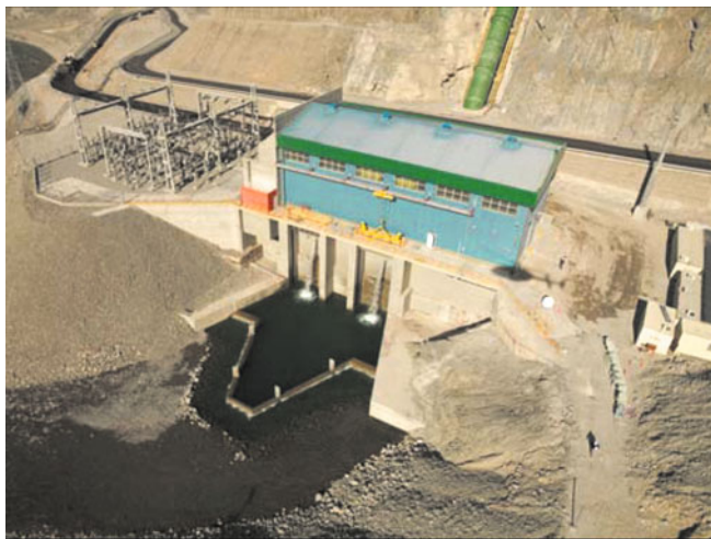
Рис. 5. Здание ГЭС Лос-Караколес
