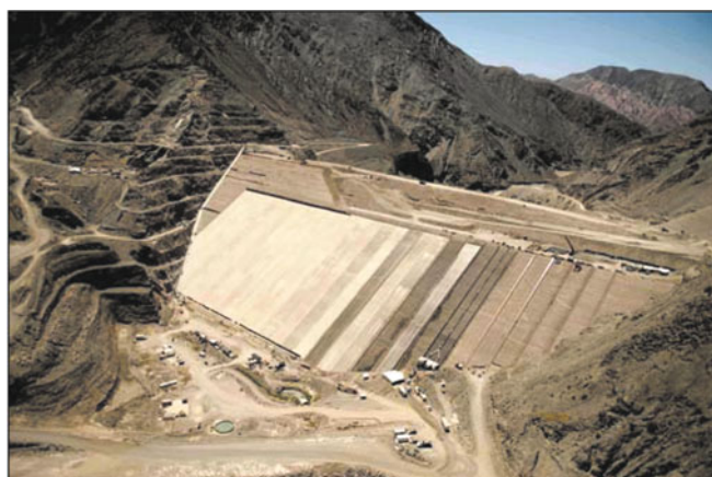
Рис. 2. ГЭС Лос-Караколес: строительство плотины с железобетонным экраном
