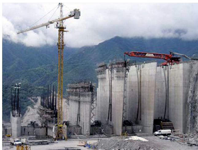
Рис. 10. Строительство водосброса ГЭС Эль Кахон
