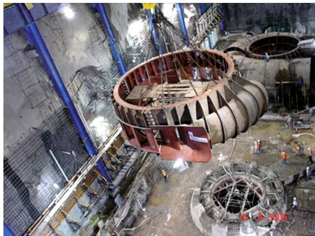
Рис. 6. ГЭС Эль Кахон: монтаж статора гидротурбины
