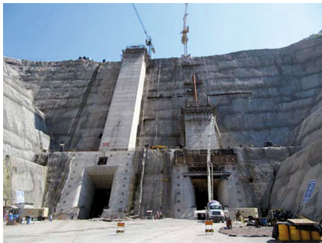
Рис. 19. Водоприёмник ГЭС Ла Йеска
