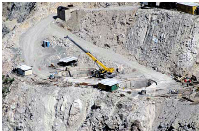
Рис. 16. ГЭС Ла Йеска: вертикальные шахты опорного зуба
