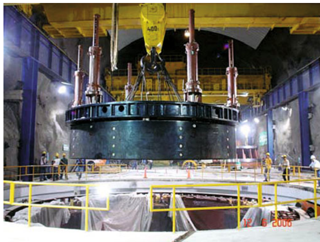
Рис. 8. ГЭС Эль Кахон: монтаж крышки гидротурбины с кольцевым затвором
