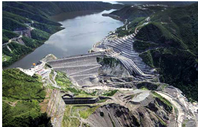
Рис. 18. Плотина и каналы водосброса ГЭС Ла Йеска
