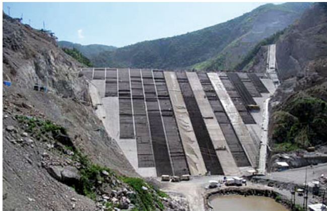
Рис. 17. Плотина ГЭС Ла Йеска: бетонирование экрана
