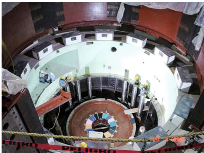
Рис. 7. ГЭС Эль Кахон: кратер гидроагрегата с установленным рабочим колесом
